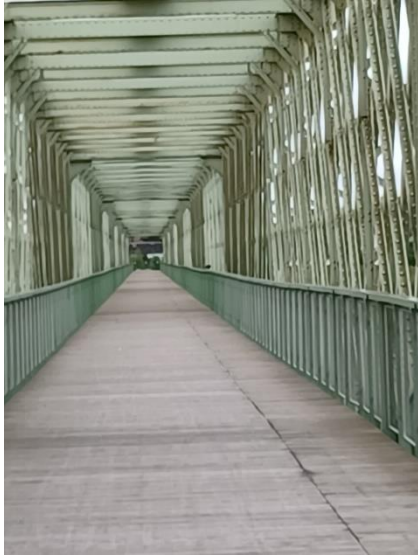
Passerelle La Loire à vélo
