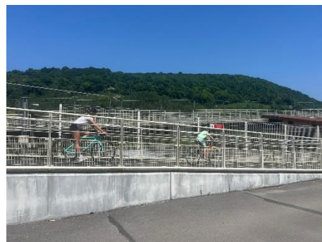
Passerelle à vélo comme à Vienne
